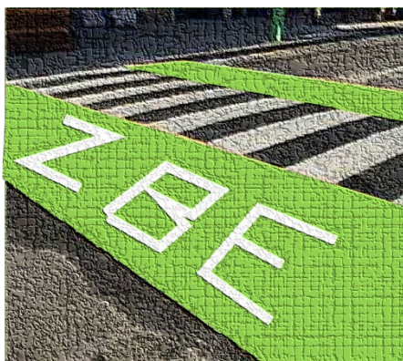
Figura 46. Señalización horizontal en los accesos a la zona de bajas emisiones.
